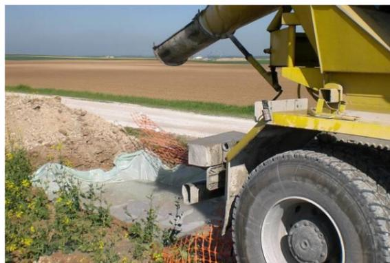
Photo 121 : Exemple de récupération des laitances de béton
