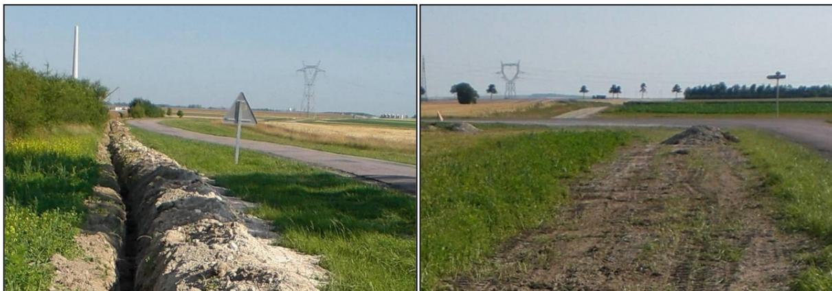
Photo 123 : Rebouchage de tranchée après passage des câbles électriques (Source : BE Jacquiel et Chatillon)
